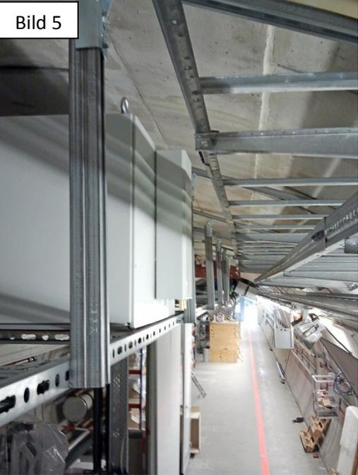
Die Prototyp-Schränke in Mockup Tunnel sind 60 cm hoch. Alle Andere Schränke werden als 50 cm hohe Version (9 HE) bestellt. Der Wärmetauscher wird horizontal montiert.
