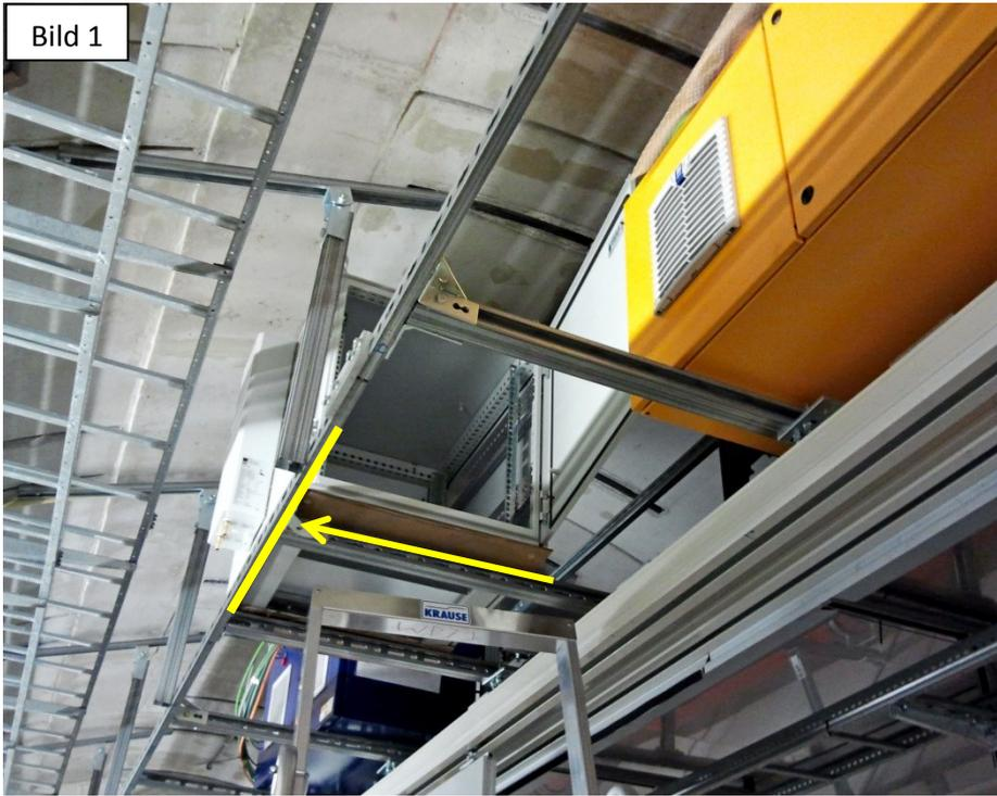
Das erleichtert den Zugang zu dem Schrank deutlich und lässt sogar eine von Türen komplett öffnen.
