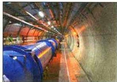
Über 27 Kilometer reihen sich (links im Bild) die Magneten im Tunnel des Cern aneinander.
