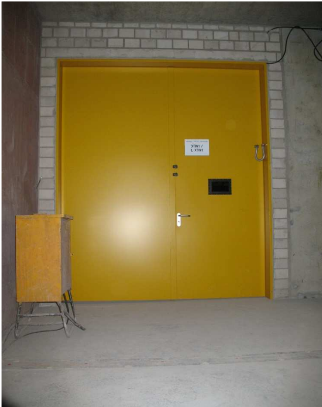
Interlocktür X11 für Zugang XTIN1
